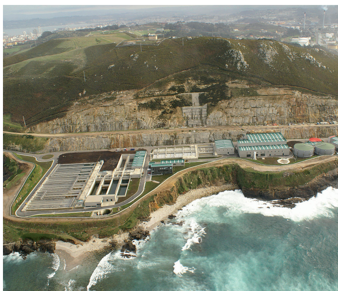
Estación depuradora de aguas residuales de Bens. La Coruña. Galicia.
